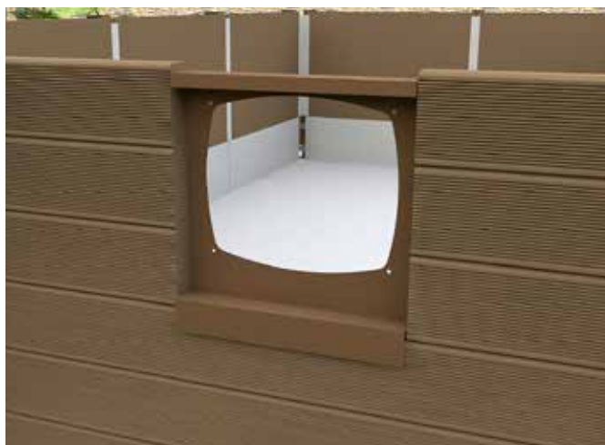
Mise en place de la plaque pour fixation du skimfiltre.
